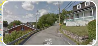
Un tronçon plus étroit et abrupt
